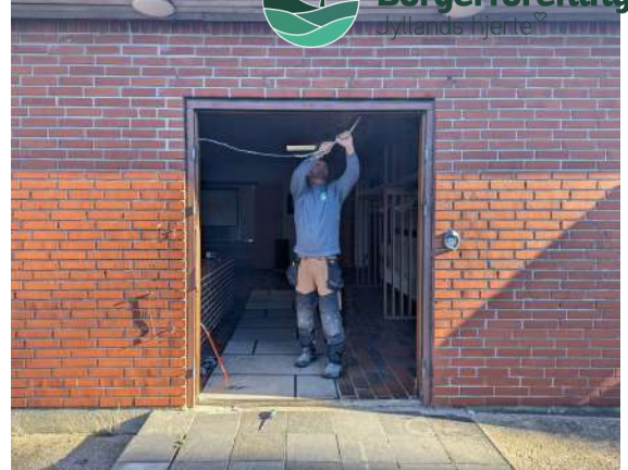
Tømrer Morten Breum i gang med at montere en ny hoveddør
