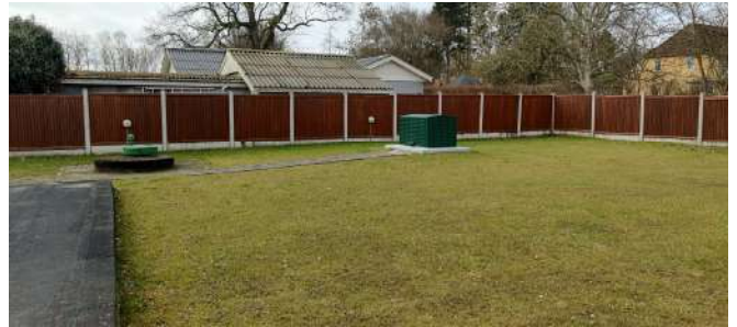
Renoveret boring 3 på vandværket til højre
