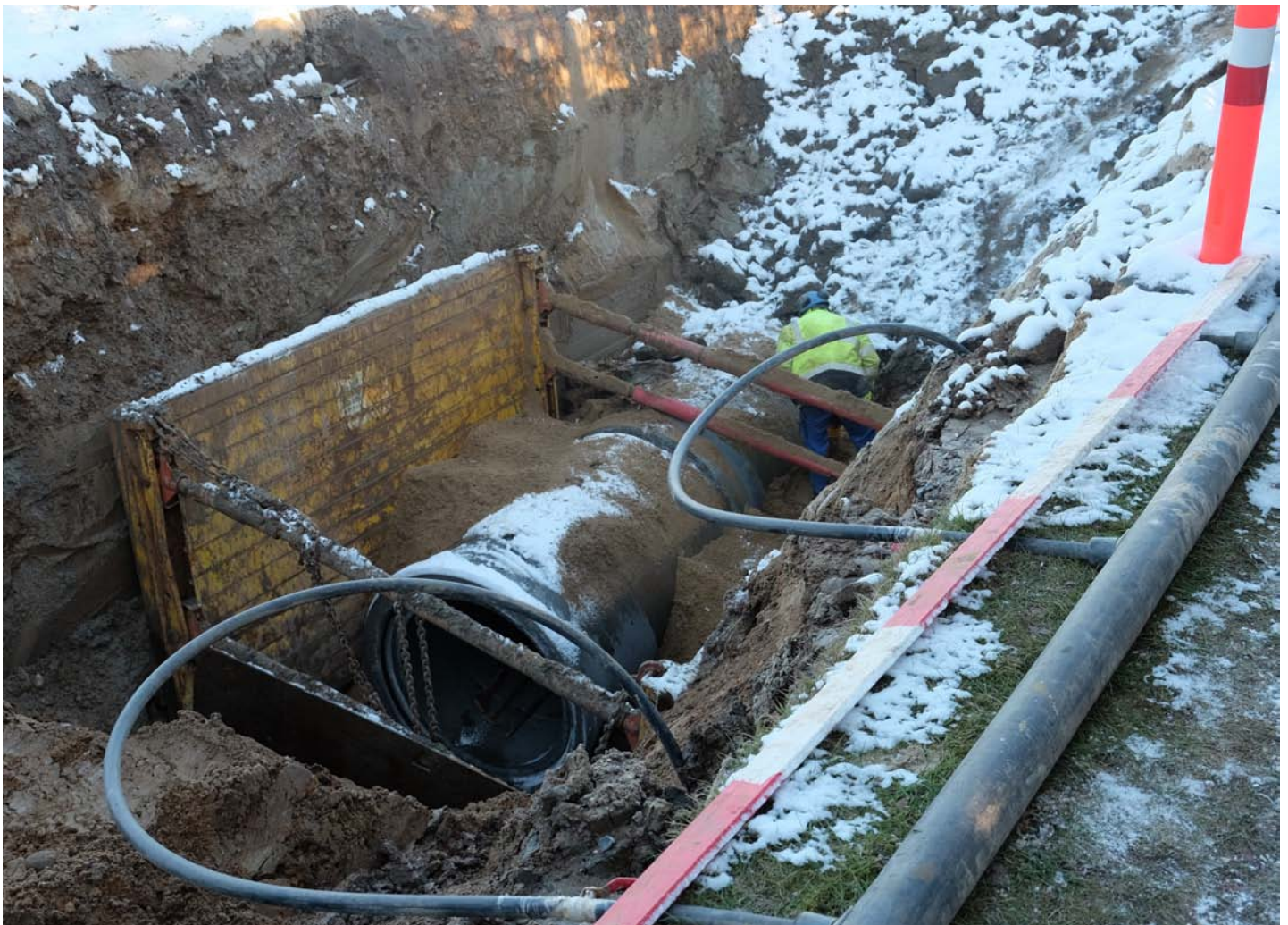
De sidste rør graves ned d. 24. februar (foto: Tina B. Jespersen)
