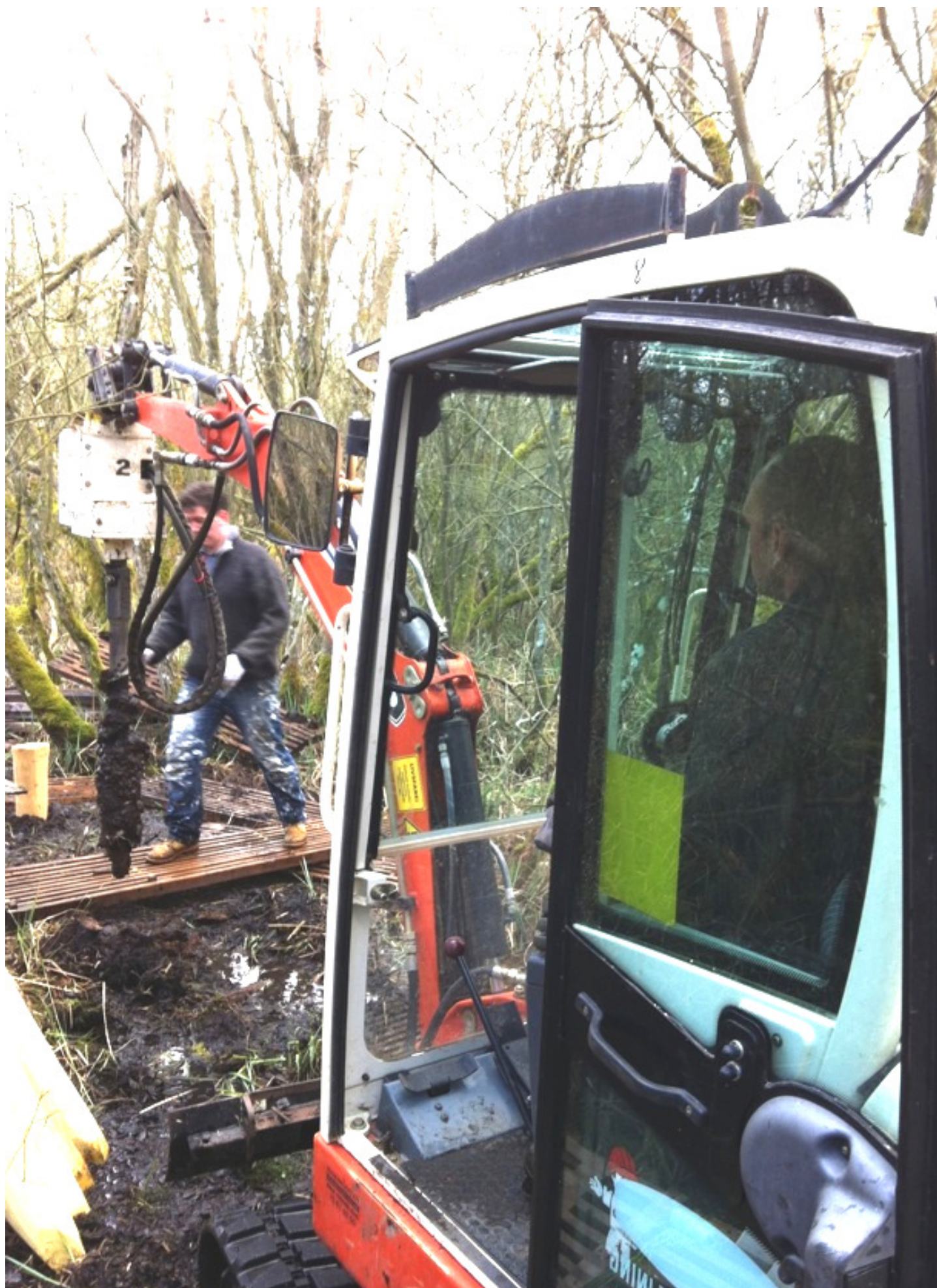
Frivillige fra Stjær og fra Dansk Ornitologisk Forening hjælper entreprenøren Woodways med at etablere en gangbro ud til Tåstrup Sø.
