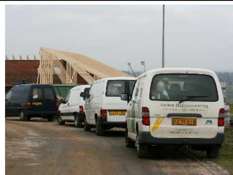
Travlhed på byggepladsen
