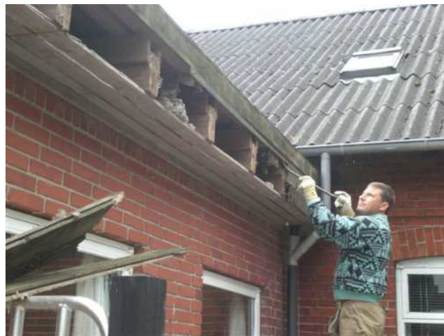
Tommy fjerner de gamle sternbrædder
