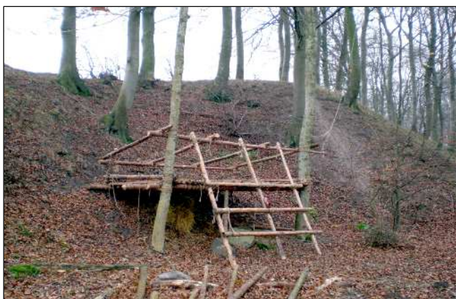
Dette shelter er under opførelse af spejderne, nær Stjær
